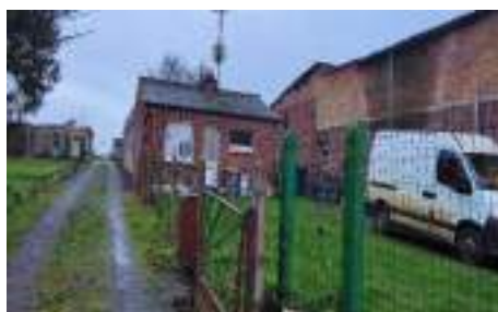
Devant le futur logement
